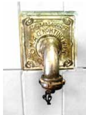
Obr. 8. Koncovka systému centrálního vysavače v hale nádraží Praha-Těšnov
