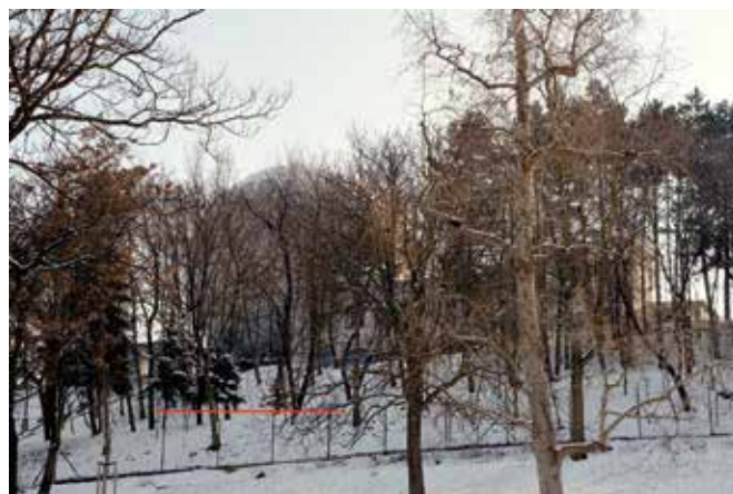
Obr. 7. Trasa linie potrubní pošty Jindřišská – Praha 10 v blízkosti bývalého libeňského plynojemu
